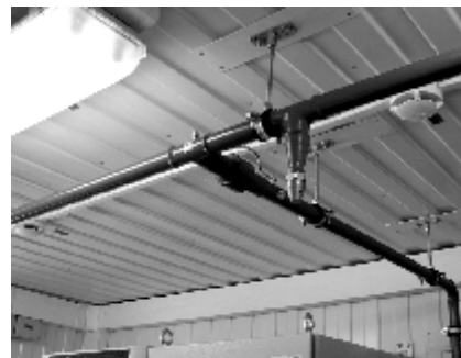
Рис. 62 Монтаж спринклера
