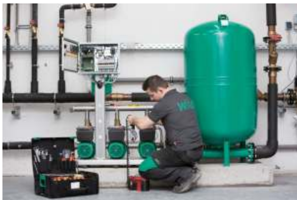
Рис. 58 Монтаж розширювального бака
