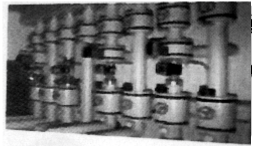
Рис. 82 Монтаж труб з теплоізоляцією
