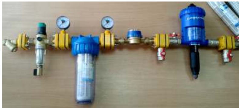
Рис. 48 Монтаж фільтрів у системі водопостачання
